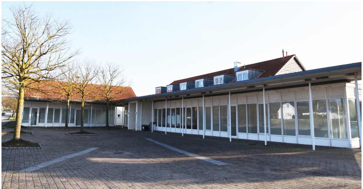
Bild: Bürgerhaus Pötenitz - Ist-Zustand
